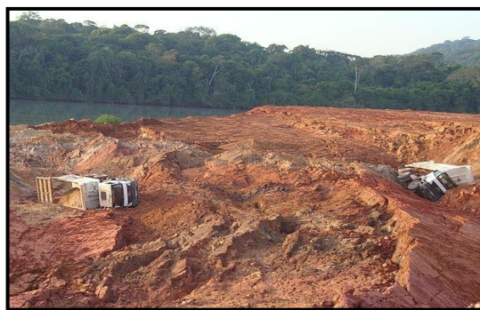
Fonte: 12ª CIBM/ Assessoria de Comunicação Figura 01: Obras da Usina Hidroelétrica Colíder
